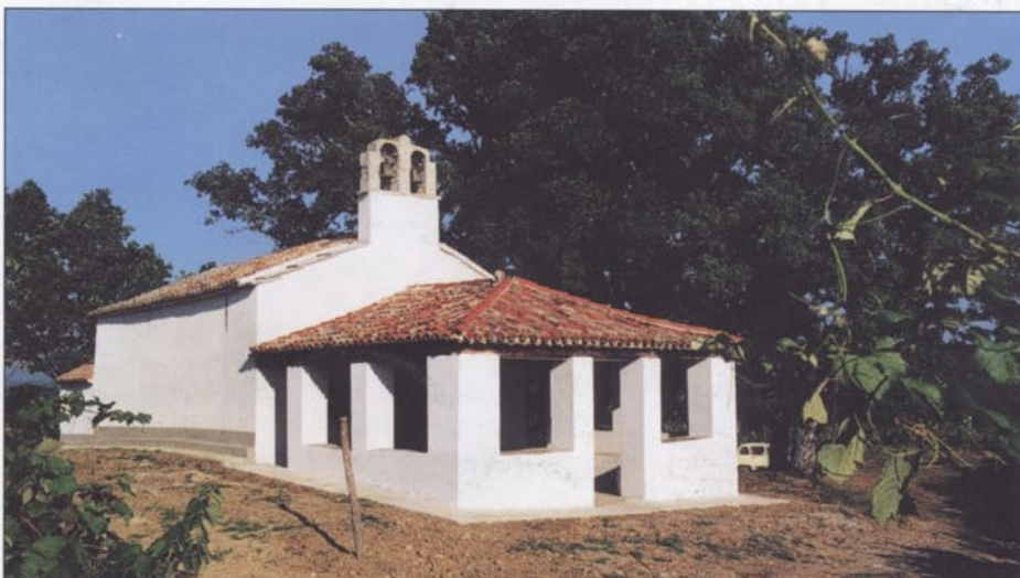
La chiesa di Subiente "Alla Natività della Vergine" appena restaurata.
