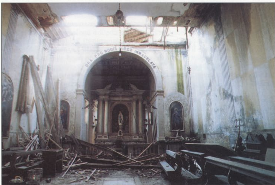
La disastrosa Chiesa dei Servi.
