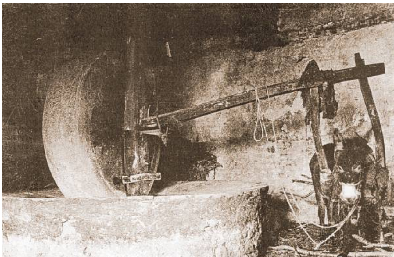
Montona 1922 (foto P. Scheuermeier AIS 705). Nel centro del basamento di pietra "basil" si innalza l'asse di legno "fuso", da cui si diparte il timone "timòn" che viene trascinato intorno al basamento da un asino. Dal lato opposto sopra la macina verticale "mola" è posto un recipiente di legno a forma di piramide conica "grot" nel quale si versano le olive da macinare
