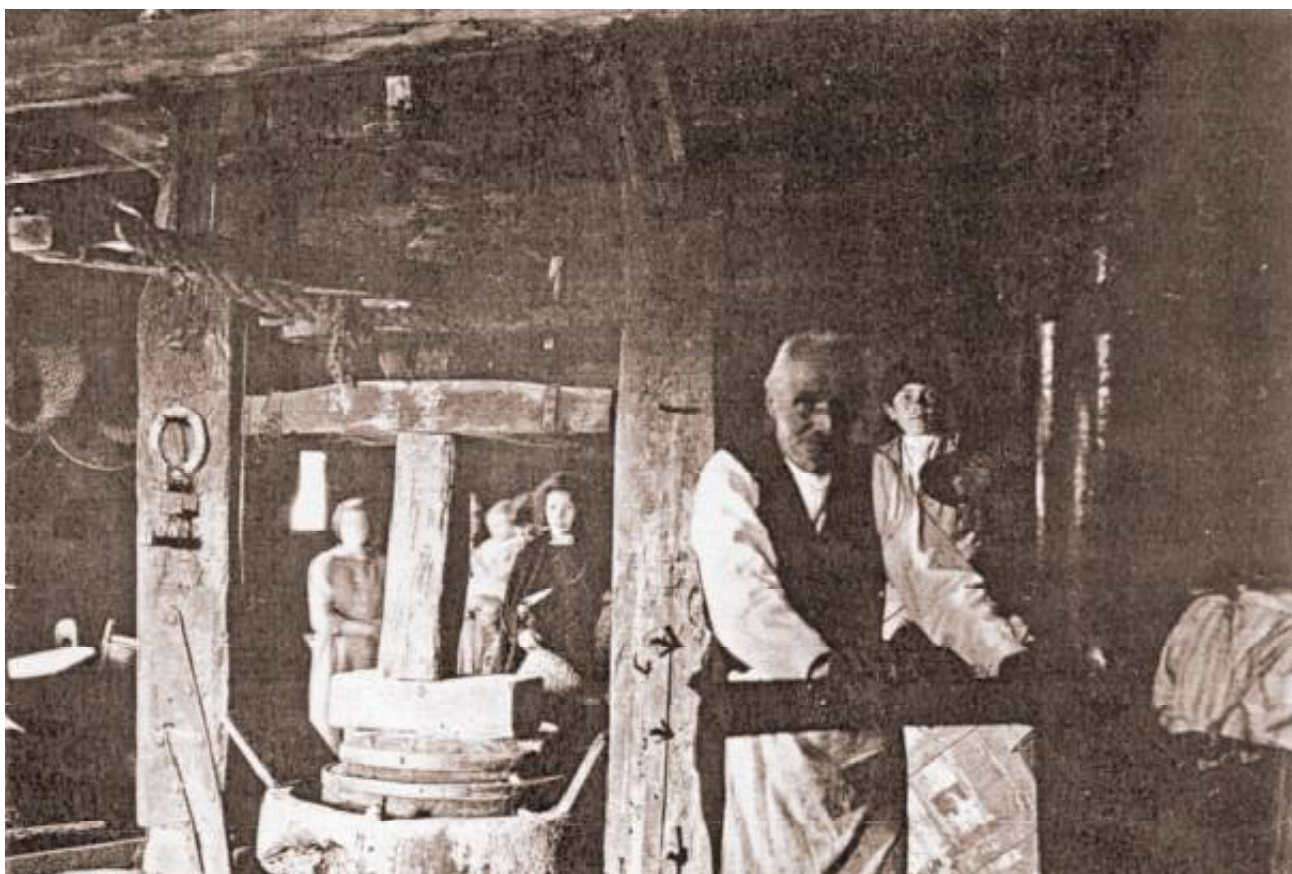
Montona 1922 (foto P. Scheuermeier AIS 706). Torchio da olive "tòrcio" con grande vite di legno "vida" tra due colonne "colone", azionata a mano con un argano "àrgheno" munito di quattro manovelle "manuele" che muove il timone "timòn"
