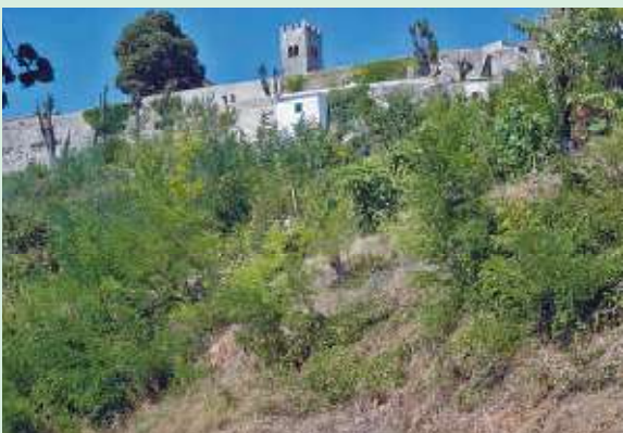
La Torre di Montona e scorcio delle mura
