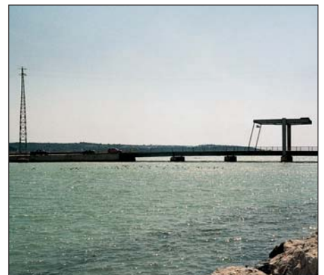
Il ponte sulla foce del Quieto
